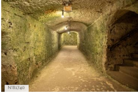
Château de la Roche-Guyon - Casemate
