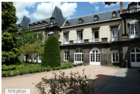
Préfecture - Cour Intérieure Hôtel Privé - Clermont-Fd
