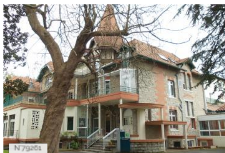
Centre de rééducation Grancher à Cambo-les-bains
