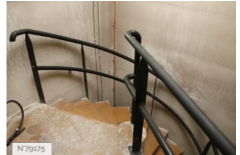
N79175 MC93 - Maison de la Culture de Seine-Saint-Denis- - Escalier d'accès au grill, tour pompier
