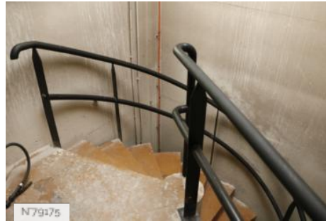
N79175 MC93 - Maison de la Culture de Seine-Saint-Denis - Escalier d'accès au grill, tour pompier
