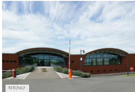
Ville de Verneuil-sur-Seine - Complexe sportif François Pons
