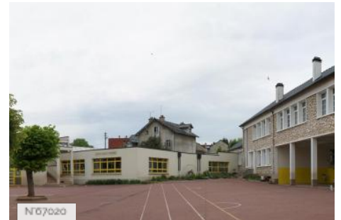
Ville de Verneuil-sur-Seine - Groupe scolaire Jean Jaurès
