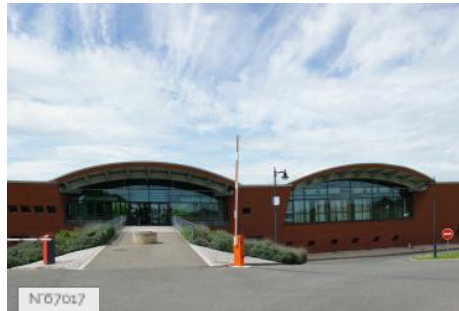
Ville de Verneuil-sur-Seine - Complexe sportif François Pons
