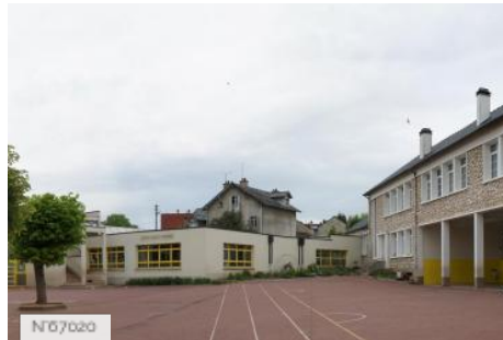
Ville de Verneuil-sur-Seine - Groupe scolaire Jean Jaurès
