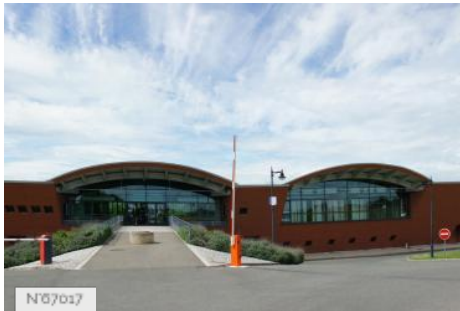
Ville de Verneuil-sur-Seine - Complexe sportif François Pons
