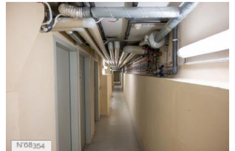
Domaine de la Grange-La Prévôté - Sous-sols
