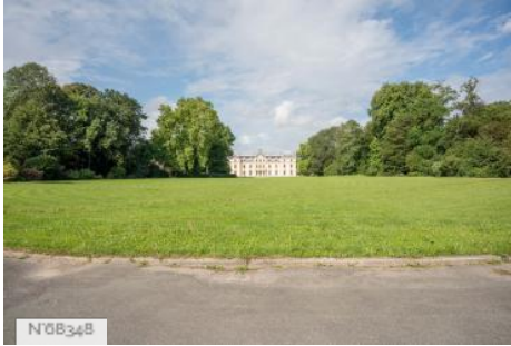
Domaine de la Grange-La Prévôté - Extérieurs
