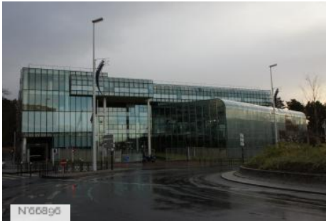
Annexe du Tribunal de Grande Instance de Nanterre - Hall
