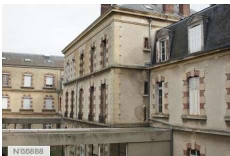
Ecole Régionale du Premier Degré Hériot - Cantine
