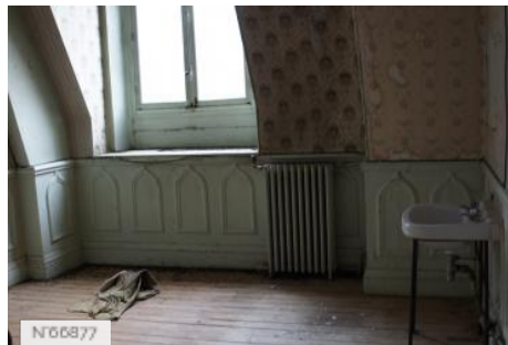
Ecole Régionale du Premier Degré Hériot - Château/Combles et couloir
