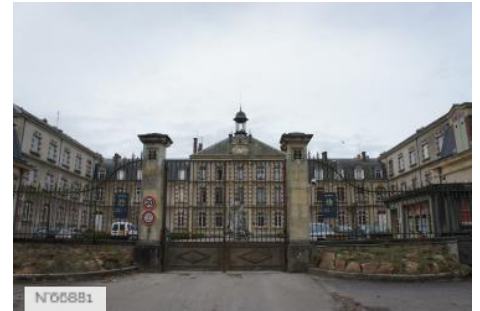
Ecole Régionale du Premier Degré Hériot - Extérieurs
