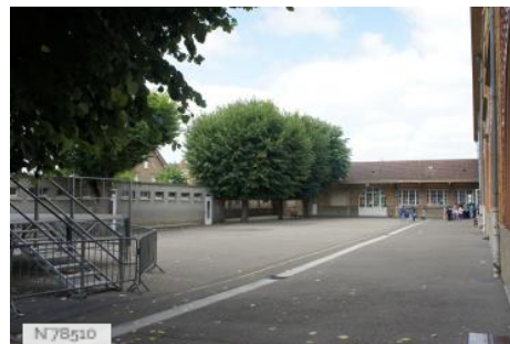
Ville des Mureaux - École Roux Calmette - Cour
