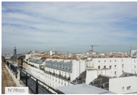
N78155 École Duperré - Terrasse
