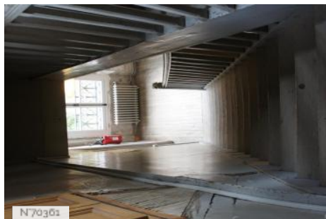
Ville des Mureaux - Château de Bècheville - Escaliers et couloirs
