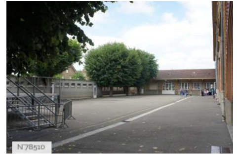
Ville des Mureaux - École Roux Calmette - Cour
