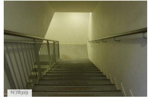
Musée de l'Orangerie - Escaliers de service
