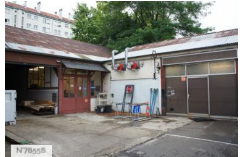
Ville de Nogent-sur-Marne - Centre Technique Municipal - Garage
