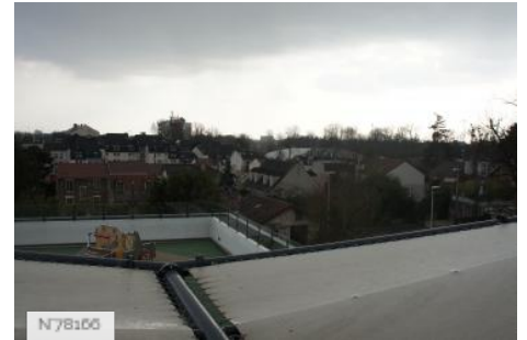
Ville de Nogent-sur-Marne - Ecole Léonard de Vinci - Terrasse
