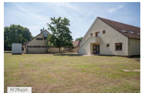
Île de Loisirs Cergy Pontoise - Bâtiments hébergement
