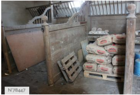
Château de Janvry - Anciennes écuries
