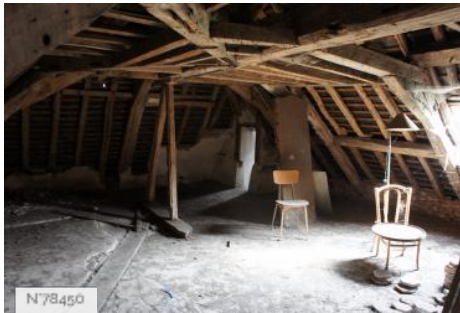
Château de Janvry - Combles
