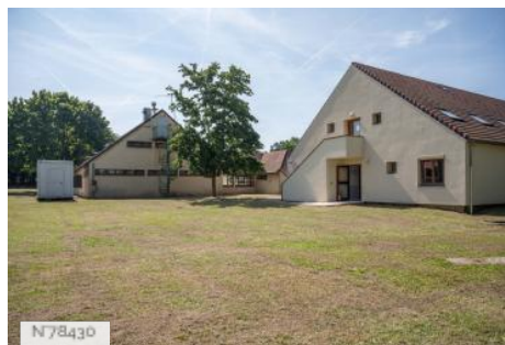
Île de Loisirs Cergy Pontoise - Bâtiments hébergement
