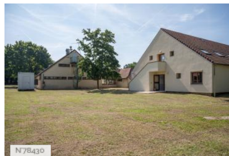
Île de Loisirs Cergy Pontoise - Bâtiments hébergement
