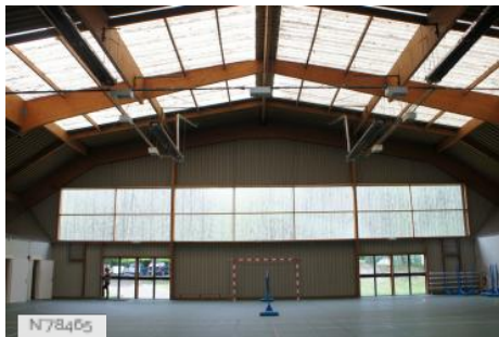
Île de Loisirs Cergy Pontoise - Gymnase
