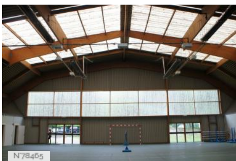
Île de Loisirs Cergy Pontoise - Gymnase
