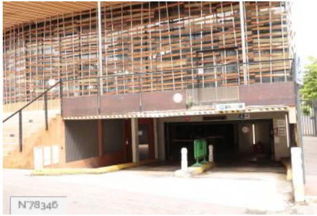
Ville de Fontenay-aux-Roses - Hall du marché
