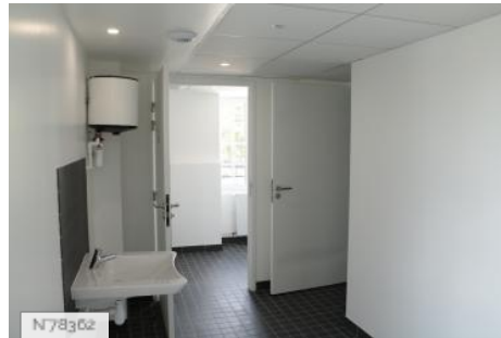
Ville de Fontenay-aux-Roses - Conservatoire/Toilettes
