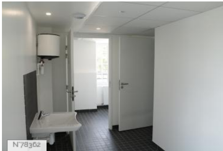
Ville de Fontenay-aux-Roses - Conservatoire/Toilettes
