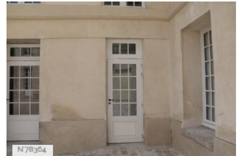
Ville de Fontenay-aux-Roses - Conservatoire/Salles de cours
