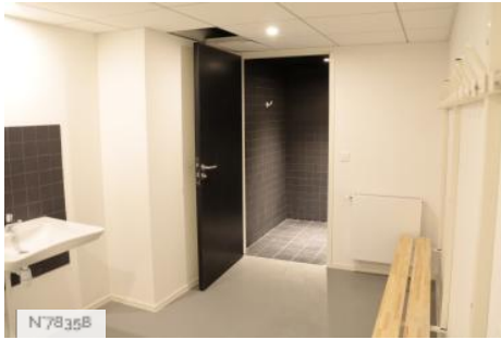
Ville de Fontenay-aux-Roses - Conservatoire/Vestiaires
