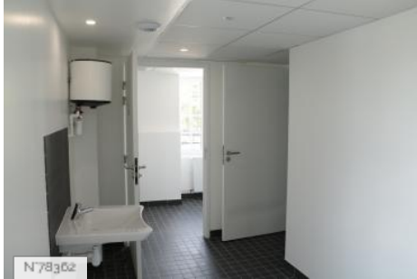
Ville de Fontenay-aux-Roses - Conservatoire/Toilettes
