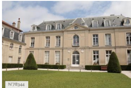
Ville de Fontenay-aux-Roses - Château de Sainte Barbe/Cour extérieure
