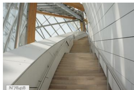
Fondation Louis Vuitton - Escalier accès terrasse haute
