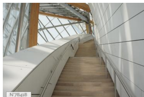
Fondation Louis Vuitton - Escalier accès terrasse haute
