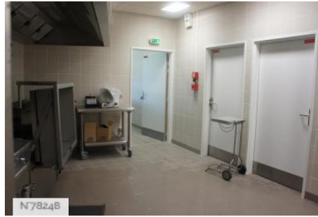
Ville des Mureaux - Le Pôle Molière - Cantine
