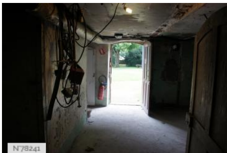
Ville des Mureaux - Maison de l'Oseraie - Sous-sol
