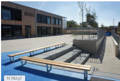
Ville des Mureaux - Le Pôle Molière - Ecole élémentaire
