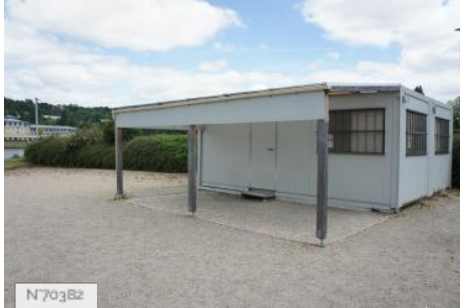
N70382 Ville des Mureaux - Boulodrome
