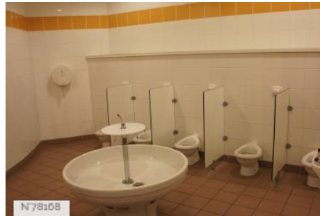
Ville de Nogent-sur-Marne - Ecole Léonard de Vinci - Toilettes
