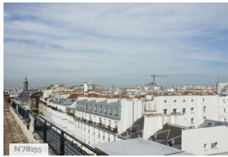
École Duperré - Terrasse
