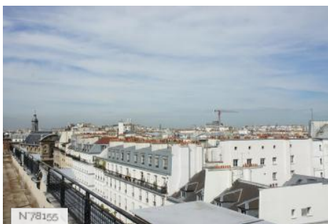
École Duperré - Terrasse
