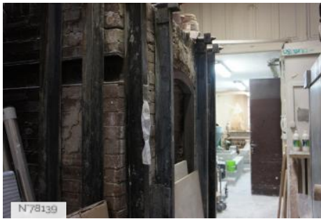
École Duperré - Salle des fours (salle 006)
