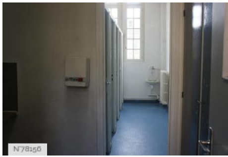
École Duperré - Toilette
