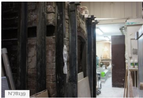
École Duperré - Salle des fours (salle 006)
