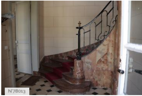
N78013 Domaine d'Ormesson - Château - Escalier
