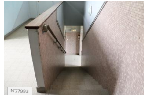
La maison d'Education des Loges - Escalier n°3
