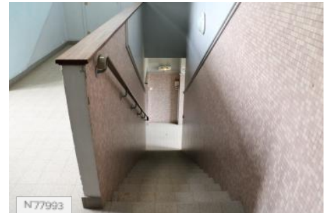
La maison d'Education des Loges - Escalier n°3
