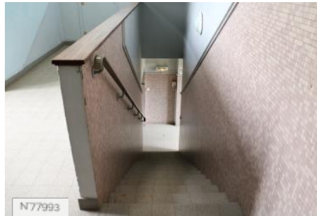
La maison d'Education des Loges - Escalier n°3
