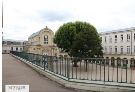
N77978 La maison d'Education des Loges - Terrasse
