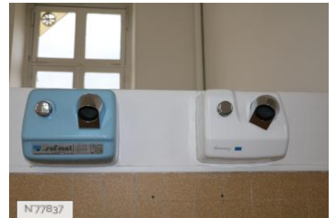
La maison d'Education des Loges - Sanitaires du dortoir allée
