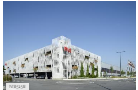
Marché International de Rungis - Parking silo
