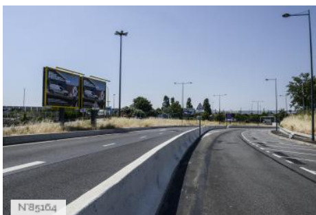
N85164 Marché International de Rungis - Route intérieure
