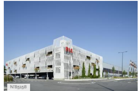
Marché International de Rungis - Parking silo
