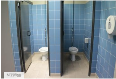
Ville d'Aubervilliers - école Jean-Macé - Sanitaires 1er étage
