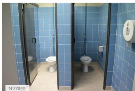
Ville d'Aubervilliers - école Jean-Macé - Sanitaires 1er étage
