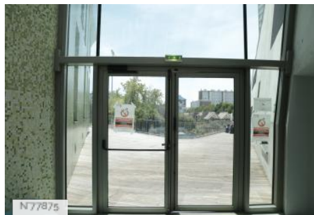
Ville d'Aubervilliers - Conservatoire - Hall conservatoire
